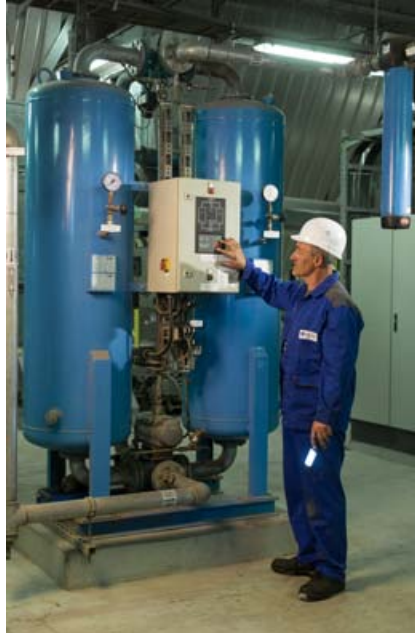
Mitarbeiter Uwe Schultz bei der Ausführung von Servicearbeiten.
